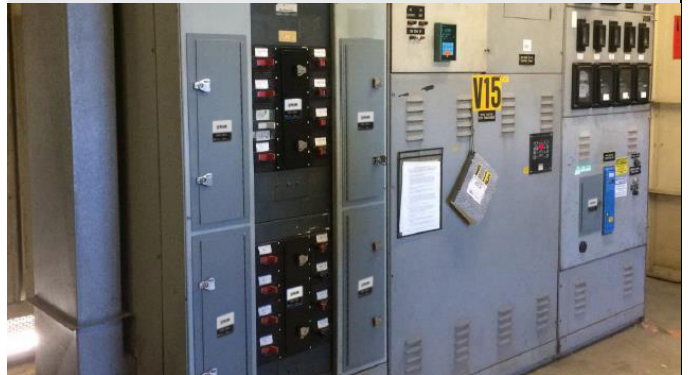
Instalación final de las ventanas de IR
